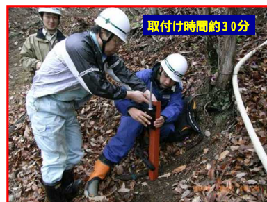
図6 センサーユニットの取り付け作業
