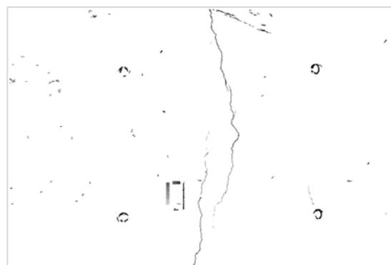
図3 ひび割れ検出結果
