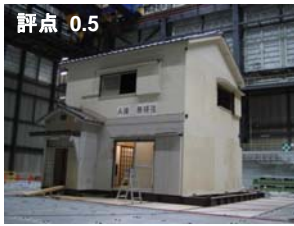
A棟(無補強)
