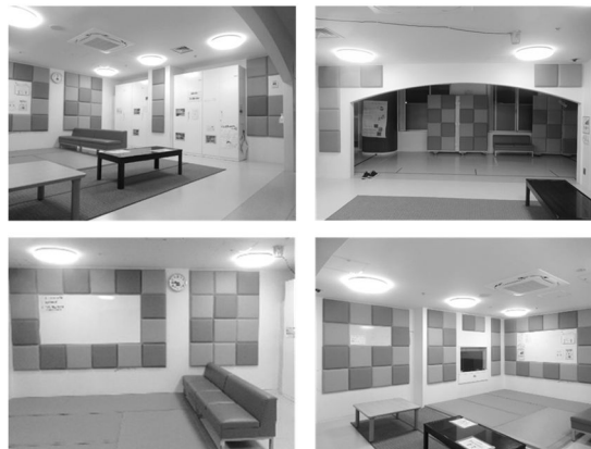
図 1：吸音パネル設置後の室内の様子
