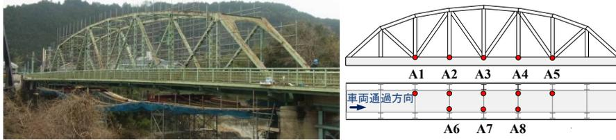
図 4-1-1 対象橋梁の写真とセンサ設置位置
