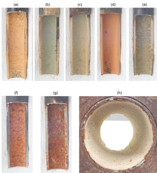
図 9 各種条件で合成したスケーリング性溶液を通水した配管表面写真 7)
