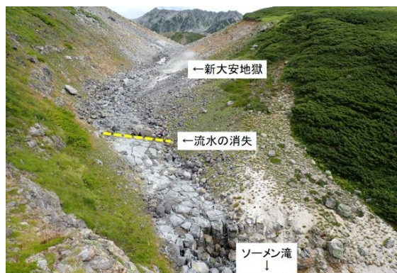
第7図 西方から見たソウメン滝の上流域
