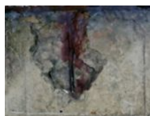
図4 鉄筋露出
