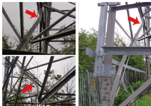
図1: 地震時の脚部不同変位による鉄塔の部材損傷事例(2007年新潟県中越沖地震)
