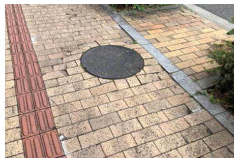
図-7 現場におけるマンホールの状況
