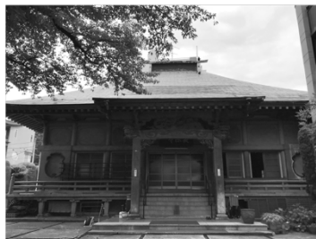
写真2) 長源寺本堂 / 山形県山形市 設計：峯田某 施工：山岸組 着工 T11.9 竣工 T13.3
