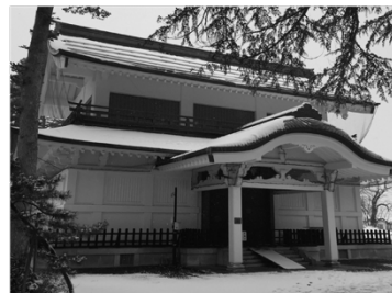
写真3) 上杉神社稽照殿 / 山形県米沢市 設計：伊東忠太 施工：未確認 竣工 T12
