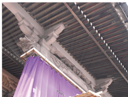
写真4) 浅草東本願寺本堂軒裏 / 東京都台東区 木製の垂木
