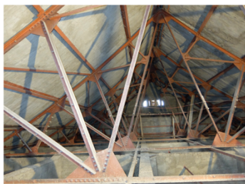
明光寺本堂及び小屋組/福岡県福岡市 設計：木田保造 施工：木田組 着工T12 竣工T13
