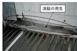
図5 庫内に発生した凍結の様子
