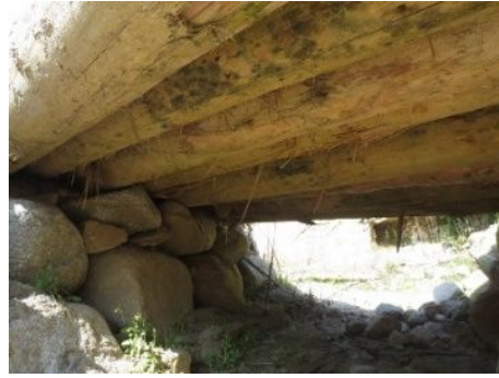
写真-1 流木材を使用した仮橋
