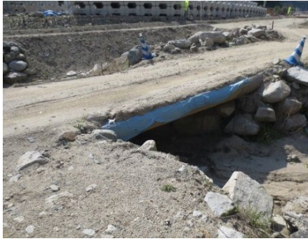
写真-1 流木材を使用した仮橋
