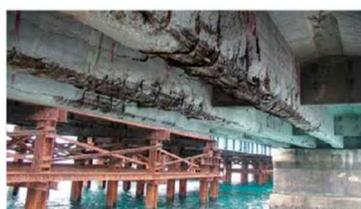
図 11 高度経済成長期に建設された橋梁の老朽化
