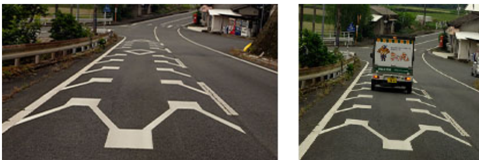
図6：イメージハンプ設置完了後の車両走行状況の確認
