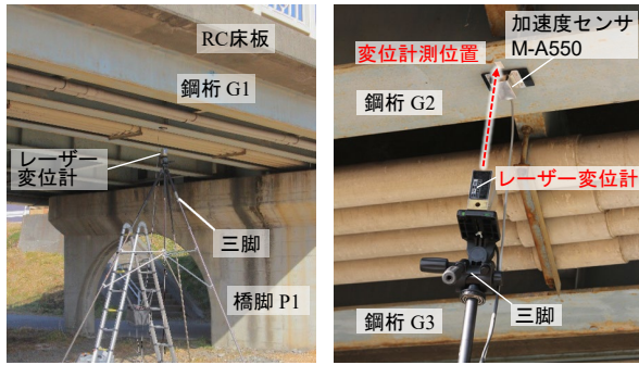
図-3 P1-P2 径間の G2 桁中央の鉛直方向変位の計測の様子
