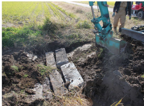
図3 直営施工による危険回避のための現場改善
