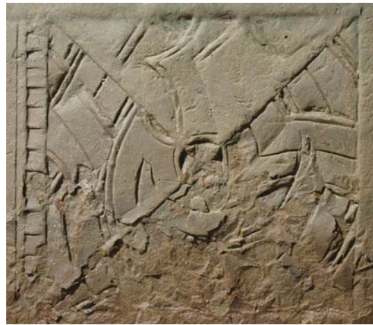
図4 千足古墳石室直弧文の劣化状況
