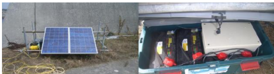
写真9. 離岸堤上に設置した食害防除システム
