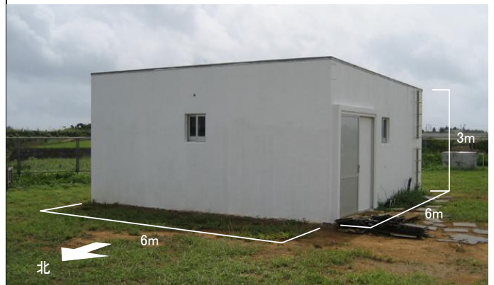
写真2 試験棟(縦6m×横6m×高さ3m)
