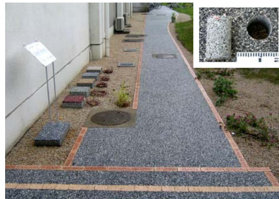
写真-2 施工後の複層ポーラスコンクリート舗装(右上はコア供試体の採取状況)
