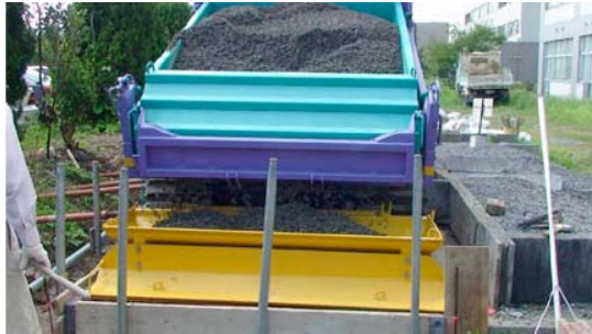
写真-3 ポーラスコンクリート敷均し機
