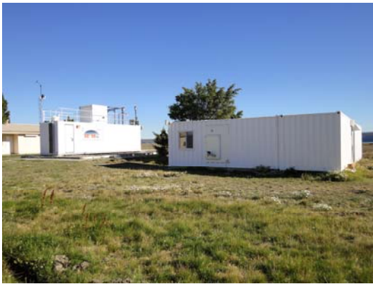
(図1) 右側のコンテナがリオ・ガジェゴスに設置したミリ波観測室
