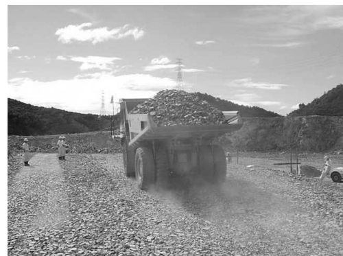
図 5 現場施工試験
