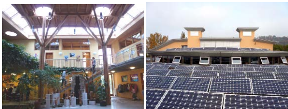
図4 ドイツの学校（左：木造の架構と自然採光，右：排気塔と排気窓，太陽電池）
