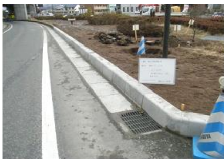
写真-6 試作した製品の現場敷設状況
