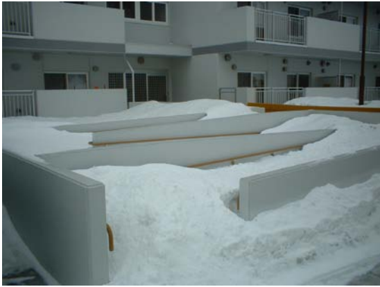
写真 3-2 積雪により使用困難なスロープ
