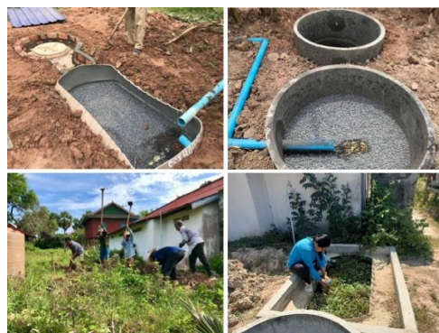
図2 カンボジアの農村における“手作り・自己管理・自分事”の人工湿地
