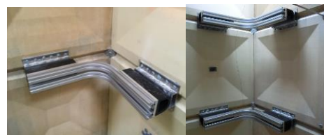
写真6 制振装置取り付け時
