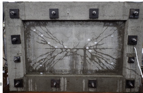
図4 ひび割れ状況
