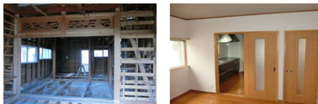
図2 改修前(左)と改修後(右)の様子(事例1・A邸)
