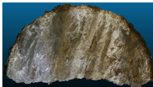
図-4 B トンネルの点群データ
