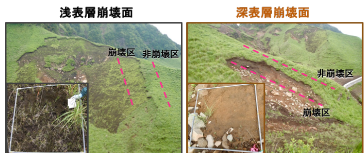
図 2. 調査した崩壊斜面の状況.
