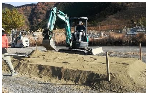
図3 試験盛土作製風景
