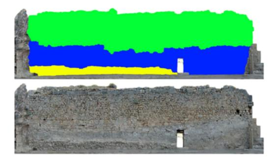
(2) 建材の風化による損耗度調査について小口・浦野は、Pundit PL200 一式(FTS 社製、解析ソフト含)を使用し、石材の年代確定を目指して非破壊調査を行なった。調査の結果、遺物の残存状況(方角・地中にあったか否か等)によって数値に大きな差異があり、パラメータの設定が重要課題であると認識された。(次図・表)
