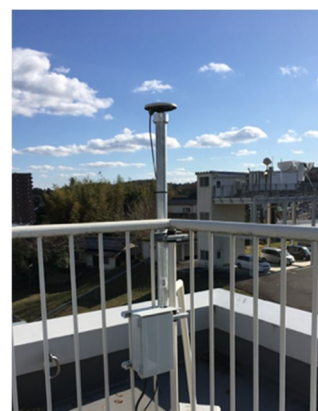
図 2 松江地方気象台における低コストシステム設置状況
