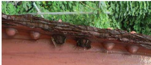
図1 腐食したリベット接合部の例
