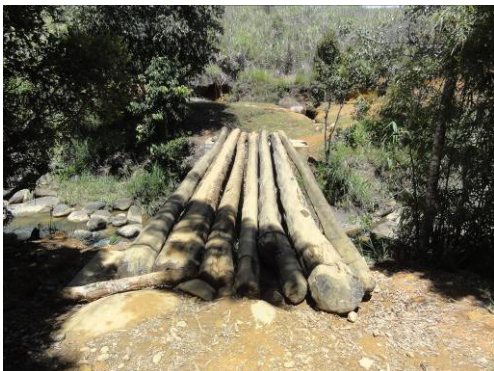
図 7 人力で架設された丸太桁
