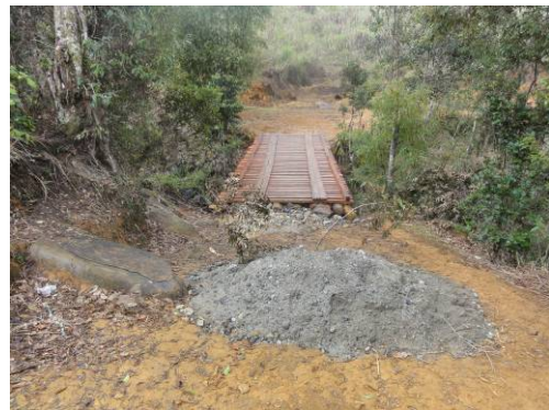
図 9 図 4 の橋が村人により架替えられた様子
