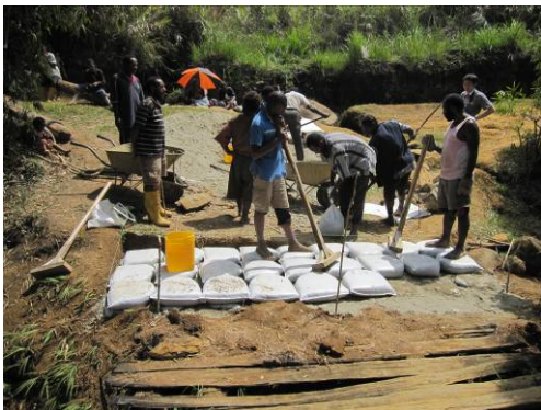
図 5 「土のう」を利用した橋台作成状況
