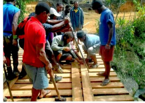
図 8 横桁を設置する住民
