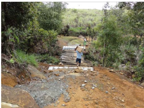
図 6 両岸の橋台が完成した様子
