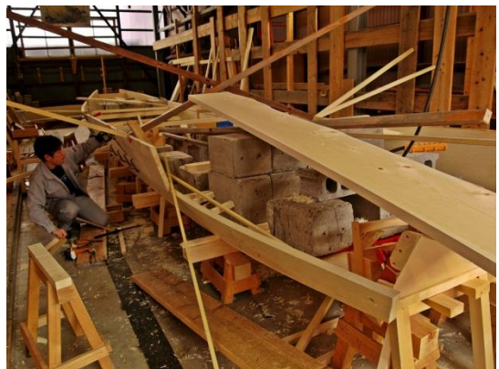
岐阜市営の鶺鴒観覧船造船所* ここでは若手船大工とベテラン棟梁が一緒に作業し、建造技術を継承している
