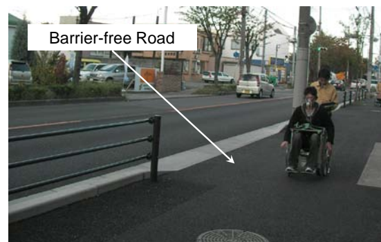
図 10 波打ち路面解消工事後の計測
