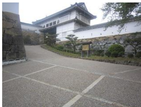
写真3 姫路城における「平成の大修理」に伴うバリアフリーの事例(路面整備による段差解消)
