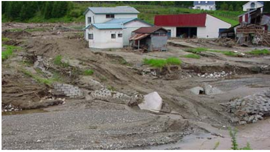
図-1 洪水氾濫による被害
