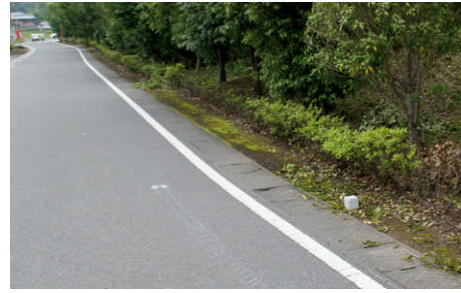
図-5 路肩設置検出実験場所
