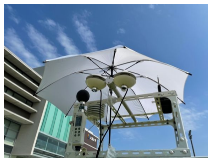
図 2 測定機取付状況
