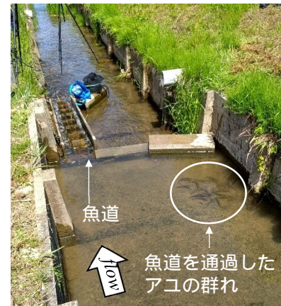
写真-3 設置した魚道を遡上したアユ
