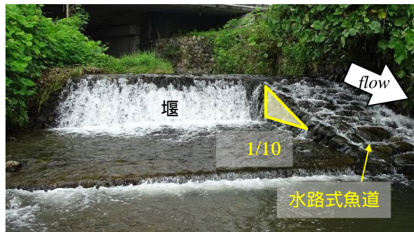
写真-1 急勾配な水路式魚道の事例 (T川)
