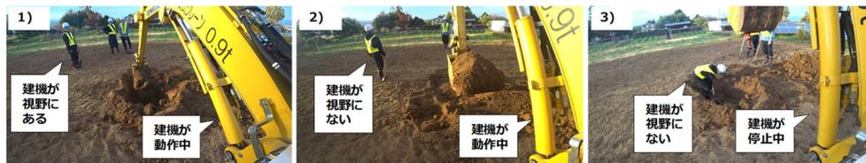
図 7. 作業員の挙動と建機の挙動の組み合わせ例
