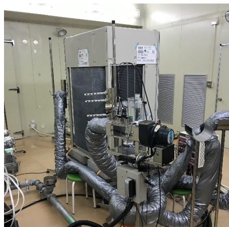
図2 負荷固定試験の様子(室外機)
