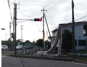
写真2 電線へのシート状飛来物の付着
