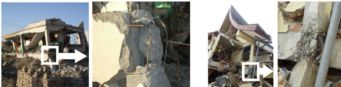
図1 研究の背景：基規準を満足しない配筋による人命に関わる被害事例 （左：パキスタン・カシミール地震，右：インドネシア・スマトラ島沖地震）
