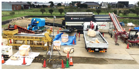
写真-2 実機試験全景
