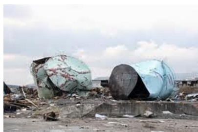
図1 津波によるタンクの破壊
